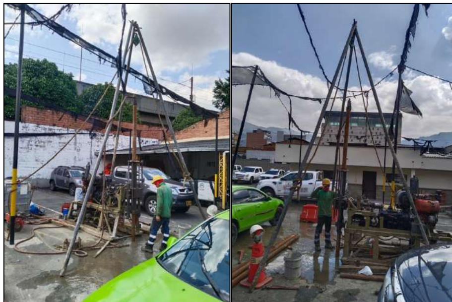
Ilustración 7 Exploración de campo con equipo de rotación
